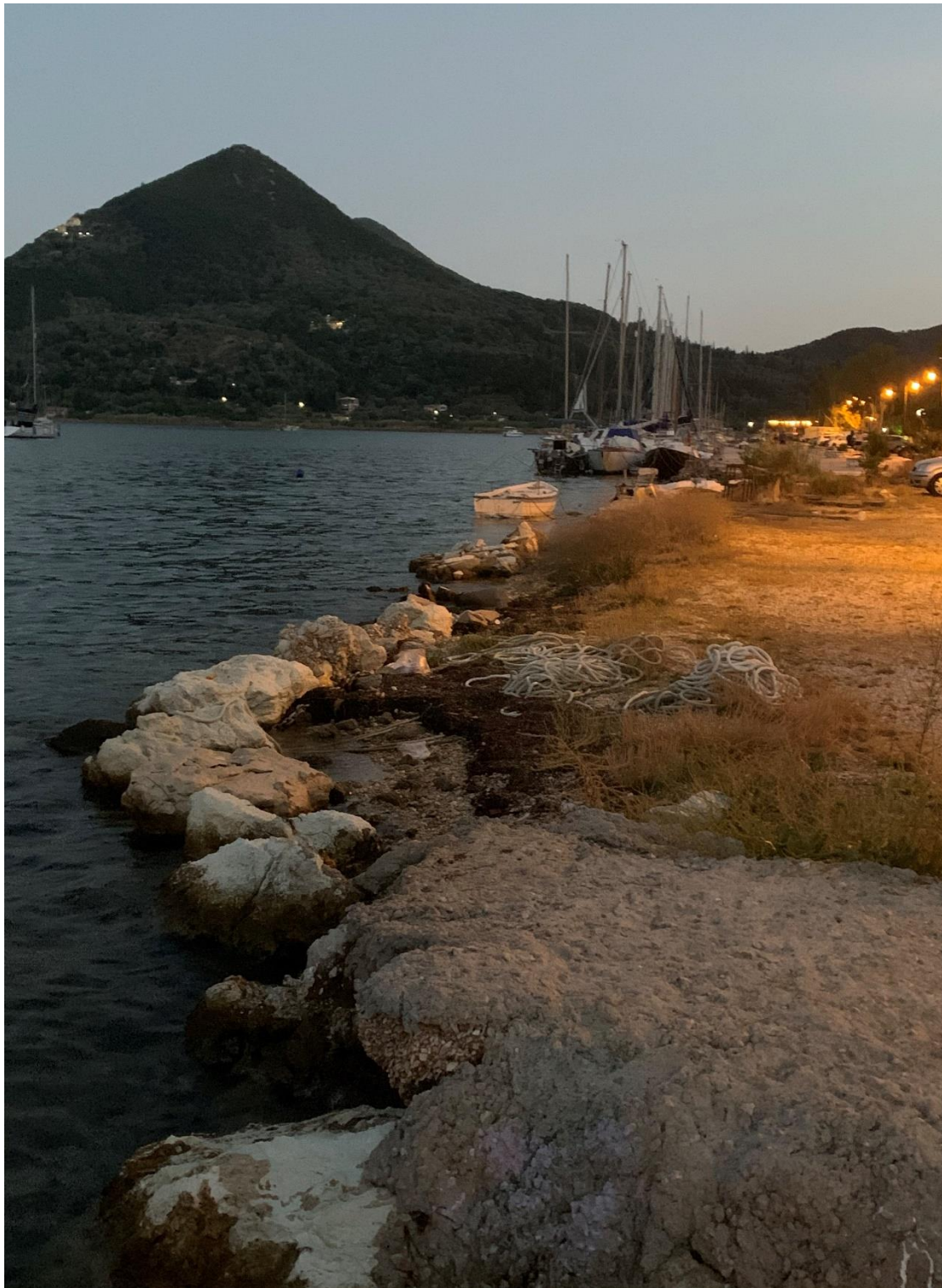
Φωτ. 13: Άποψη βόρειου τμήματος των λιμενικών υποδομών του Βλυχού
