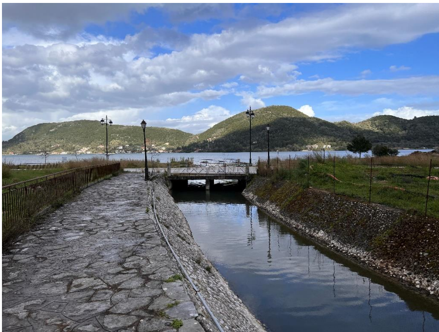
Εικόνα Φ2. Περιοχή ανάντη υφιστάμενης διάβασης πριν την εκβολή του ρέματος, περί τη Χ.Θ.: 0+050.00. – Θέαση προς κατάντη.
