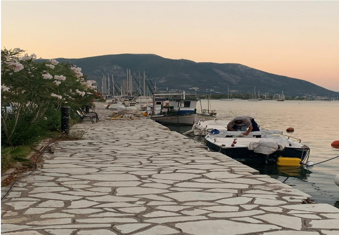
Φωτ. 9: Άποψη νότιου κρηπιδώματος λιμενίσκου Βλυχού (νότια προς κεντρικά)
