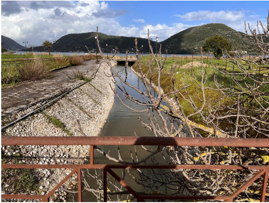
Εικόνα Φ3. Υφιστάμενο τεχνικό στη Χ.Θ.: 0+090.00. – Θέα προς κατάντη.
