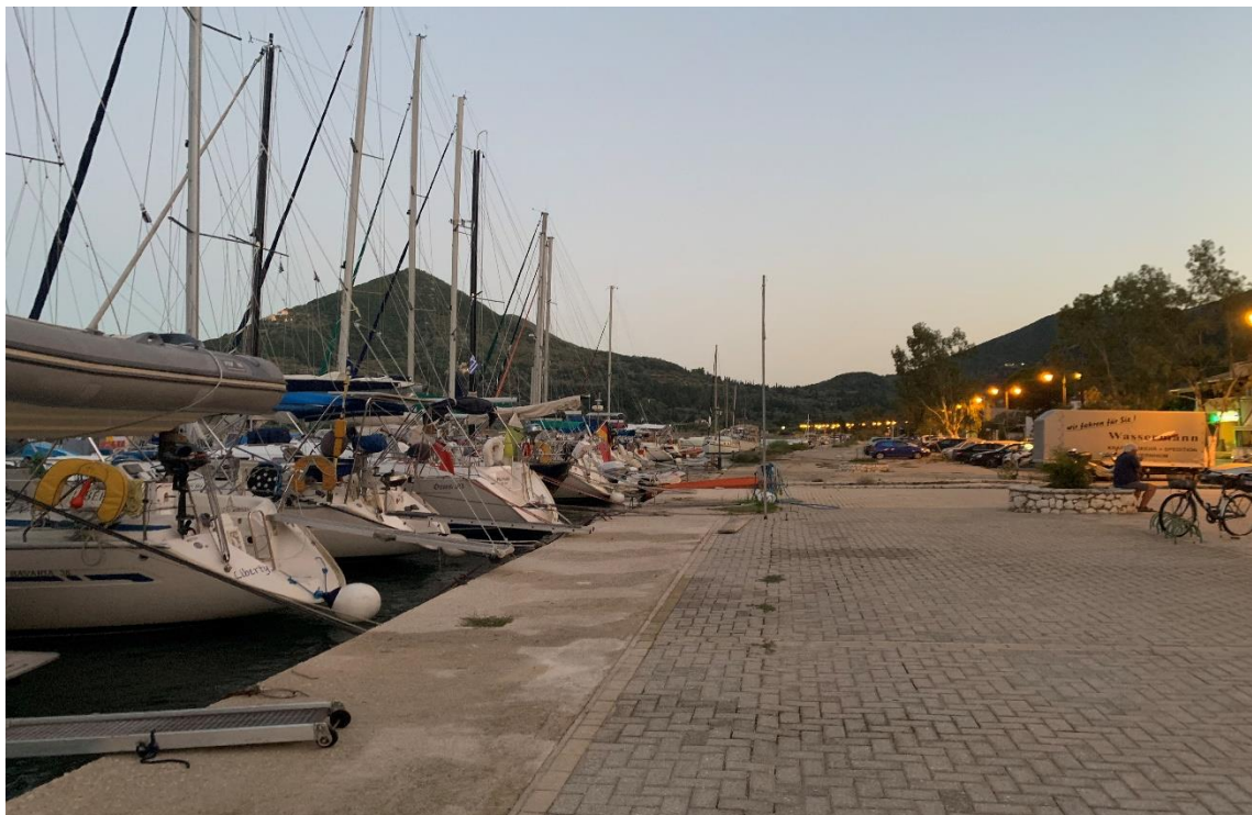
Φωτ. 10: Άποψη κεντρικού κρηπιδώματος των λιμενικών υποδομών του Βλυχού
