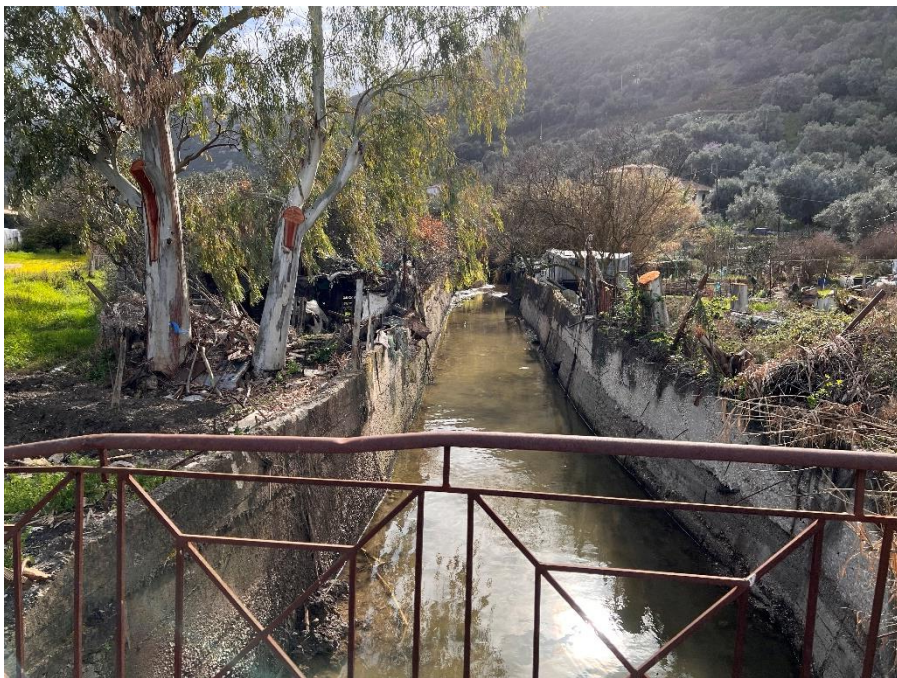
Εικόνα Φ4. Υφιστάμενο τεχνικό στη Χ.Θ.: 0+090.00. – Θέα προς ανάντη.
