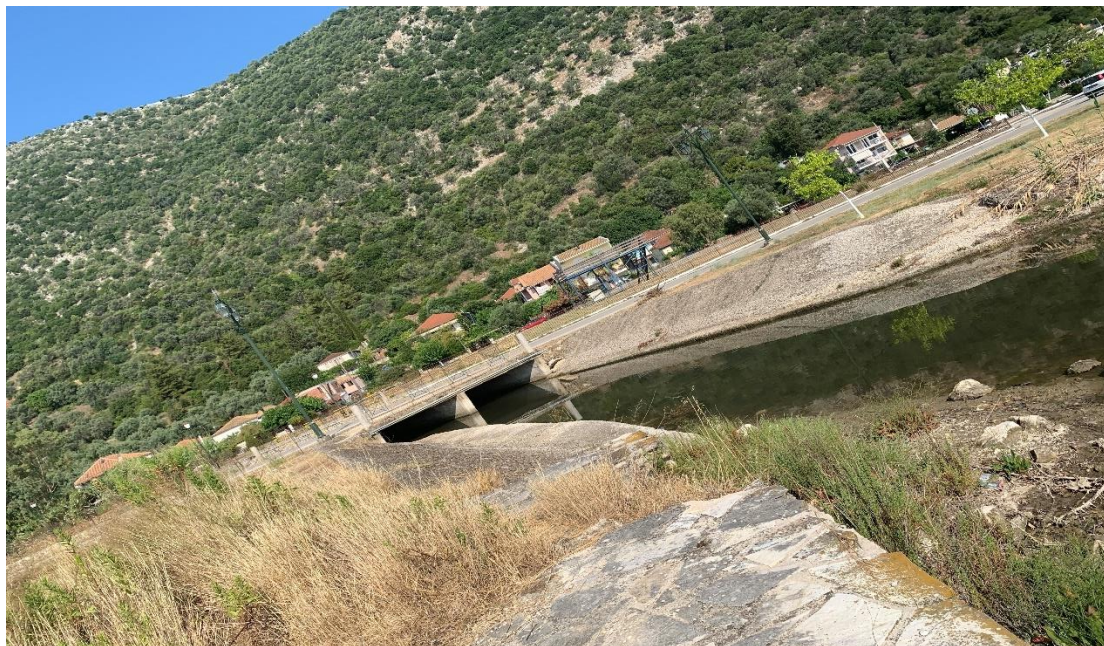
Φωτ. 7: Εκβολή ρέματος νότια του λιμένα Βλυχού
